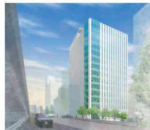
新オフィスビル外観
