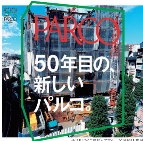
渋谷PARCO 建替え工事中 2018年8月撮影
