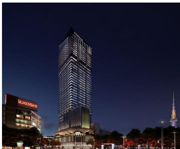
▲夜間外観イメージ (南東側)
