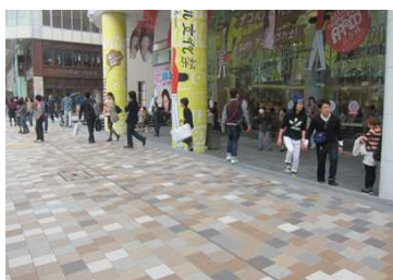
＜外周歩道の補修後＞
