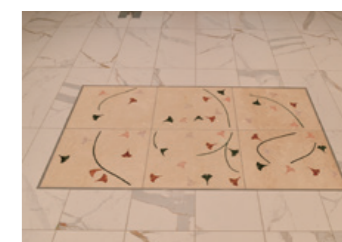
旧大丸心斎橋店北館1階 エレベーターホールから移設した銀杏並木の象嵌タイル
